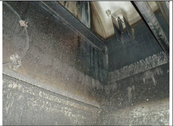
Float level (behind weir)
